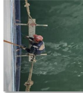
**Gambar 3.** Pelanggaran ABK Saat Melakukan Pengecatan Lambung Kapal
