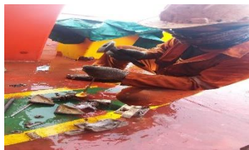
Gambar 4.2. Pembongkaran pada semiautomatic twistlock
