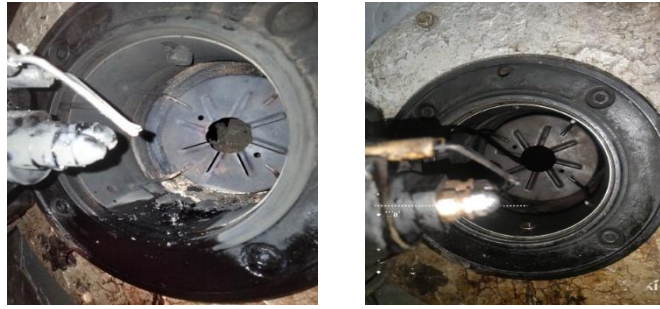
Gambar 4. Kondisi combustion head sebelum (kiri) dan sesudah (kanan) dibersihkan
